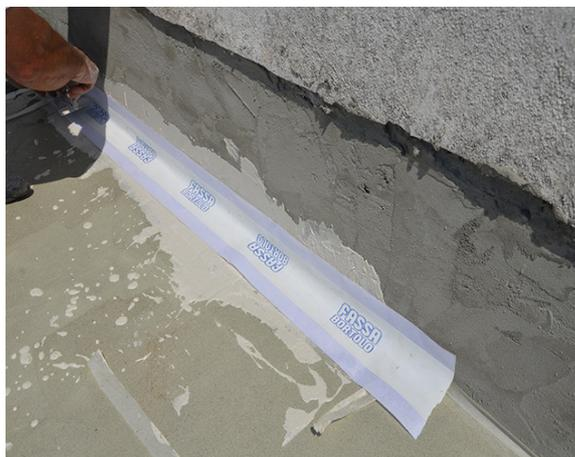
Il sistema impermeabile AQUAZIP ONE verrà applicato anche sui risvolti verticali e dopo idonea stagionatura verrà rivestito con un riporto di KI7 o KZ 35, intonaci di fondo a base di calce e cemento, per esterni ed interni, additivato con AG 15, dispersione di resine sintetiche per prodotti a base cementizia. L'intonaco di fondo dovrà essere tirato a frattazzo fine, prevedendo l'interposizione in fase di posa di una rete sintetica porta-intonaco a maglia larga.
