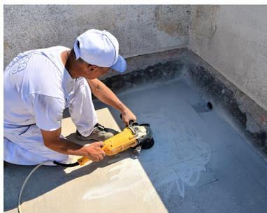
**Si sconsiglia di eseguire cicli di idrolavaggio della vecchia pavimentazione in quanto tale operazione favorisce l'apporto di ulteriori quantità di acqua nel supporto sottostante.**
