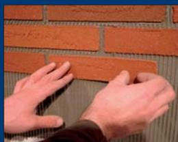
Posizionare energicamente i mattoncini FASSABRICK. Le fughe devono essere di almeno 10-12 mm.
