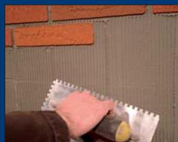
Applicare sulla parete non più di 1 m<sup>2</sup> di adesivo AMF 03 utilizzando una spatola dentata da 6 mm.
