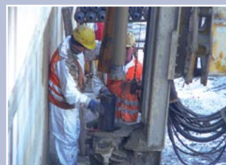
Fase 1 Perforazione (con utensile a rotocompressione, con spurgo del foro dei materiali detritici di risulta).
